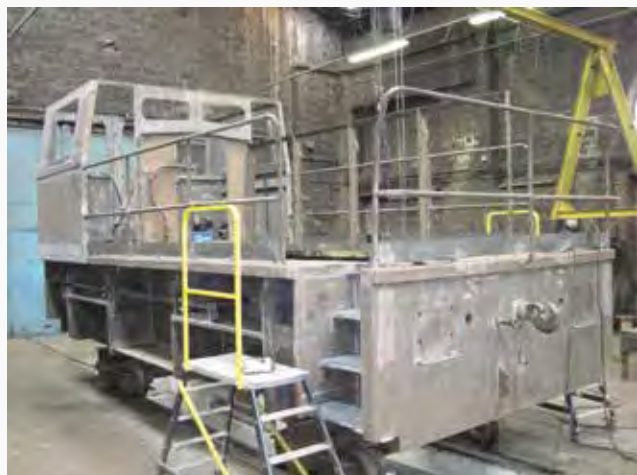
Chassis en cours de rénovation de locotracteur Fauvet Girel 300 CV Chassis of a locomotive Fauvet Girel 300 HP during renovation
