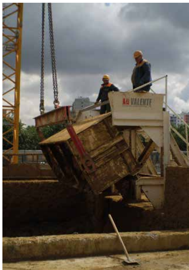
Caisse amovible sur portique Box muck with side discharge
