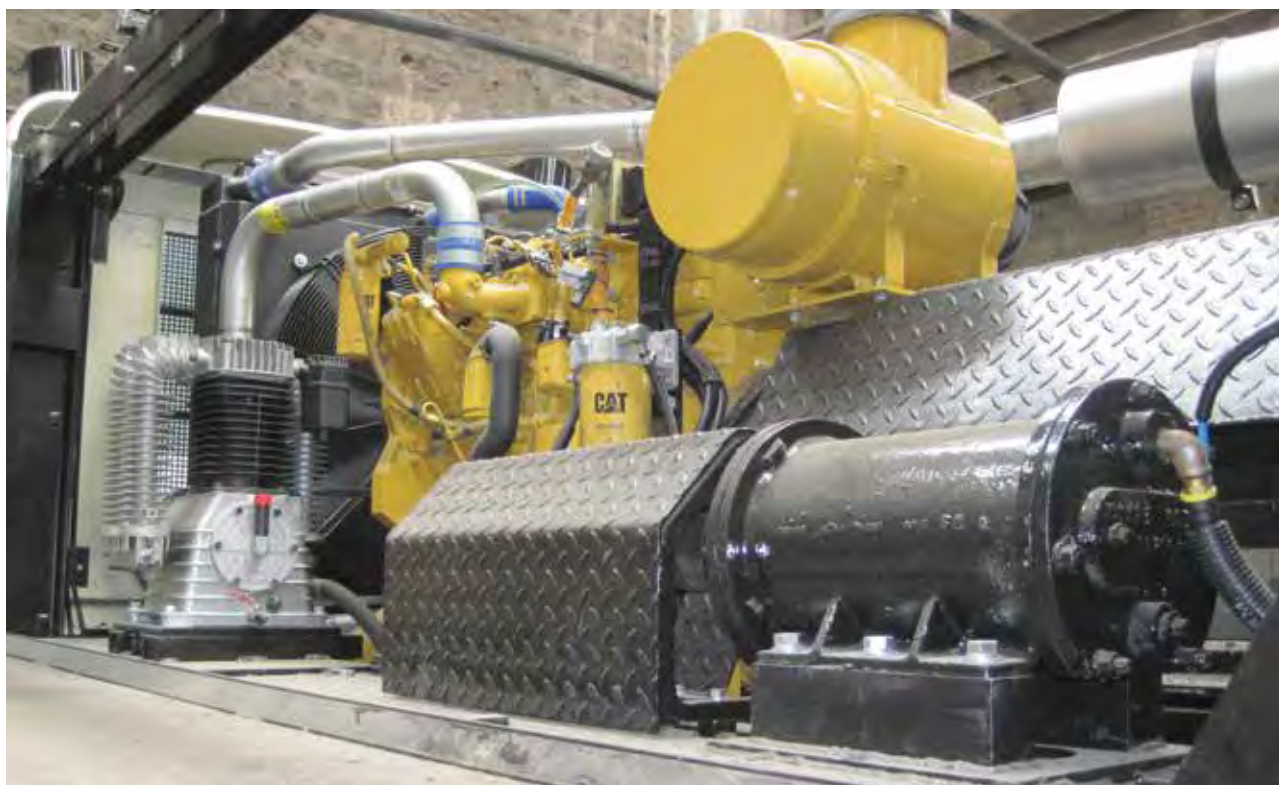
Compartiment moteur après rénovation Complete engine after renovation
