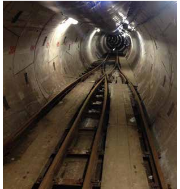
Aiguillage symétrique Symmetrical switch
